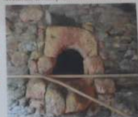
▼ Grande du grand four de Ville Basse, en tef. À l'intérieur la voûte présente un diamètre de 2,30m.
