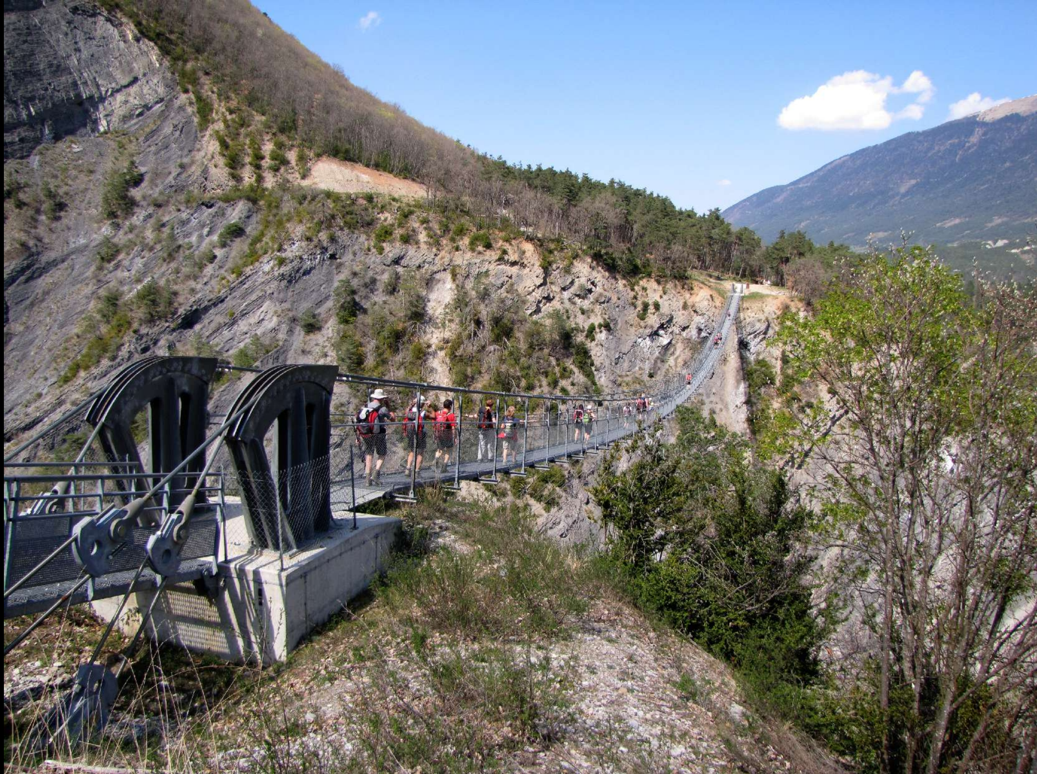
De nouveau la passerelle de l'Ebron
